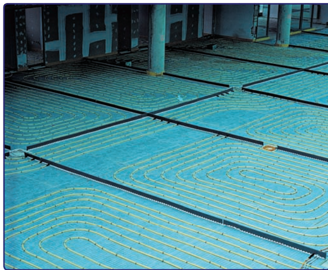
Terminal am Flughafen Dortmund mit Sonderplatte
